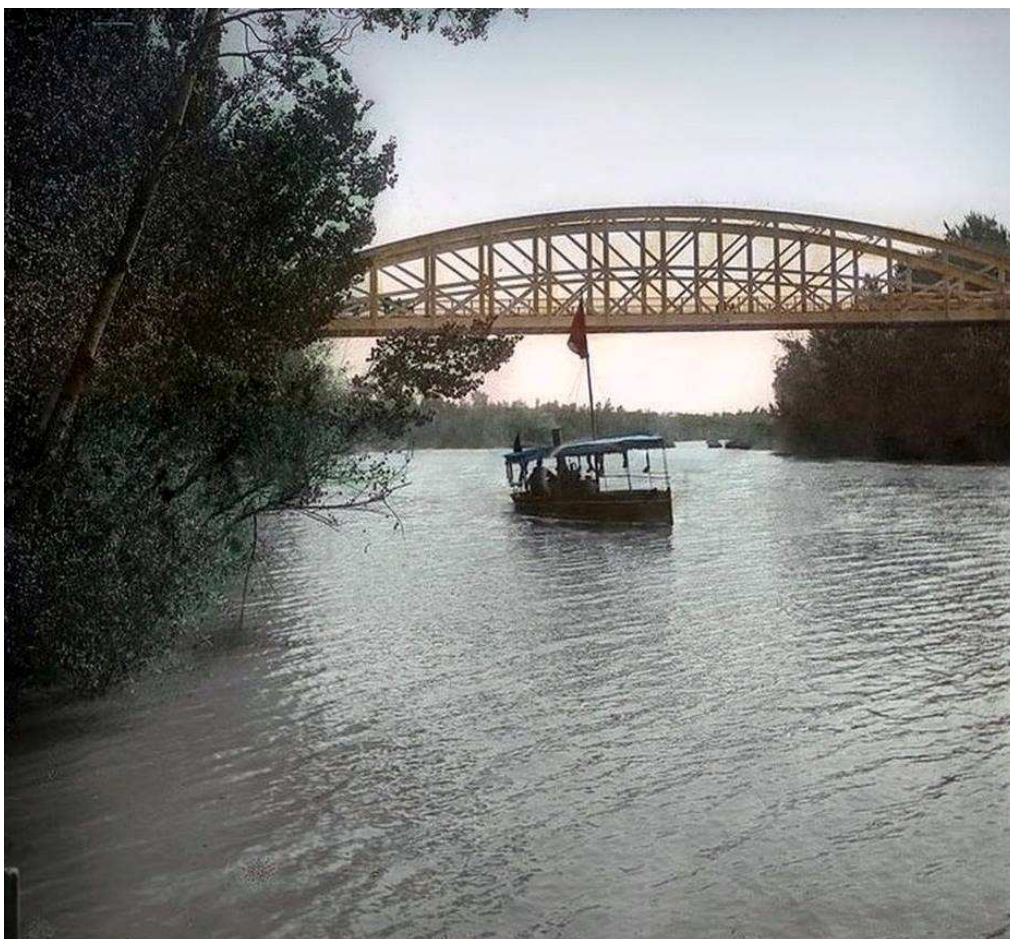
Le pont en fer sur la Pisuerga. fotografía coloreada. Casa J. Lévy et Cie, 1888-1889.
