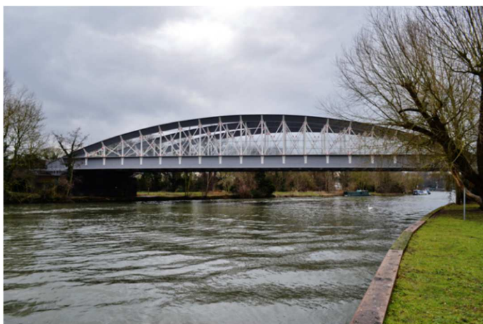
Puente del ferrocarril en Windsor construido en 1849 por Isambard Kingdom Brunel, de 57,25 m de luz.
