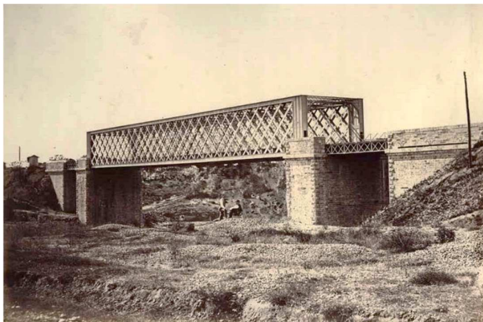
Puente en viga de celosía. Viana de Cega, 1864. Auguste Muriel.
