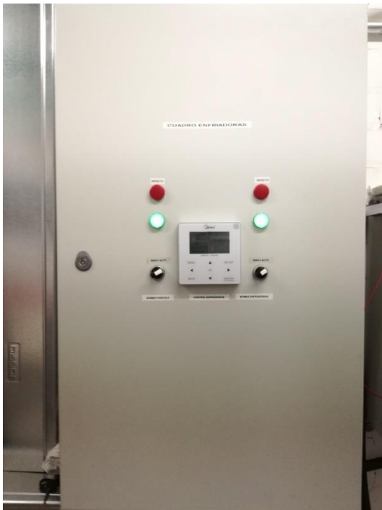
Fotos 11 y 12.- Cuadro eléctrico instalado
