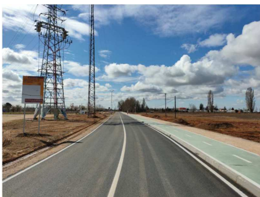
Acera y carril bici en Cañada Real
